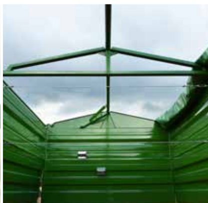
Spannseile zwischen den Mittelrungen als zusätzliche Verstärkung der Bordwände
